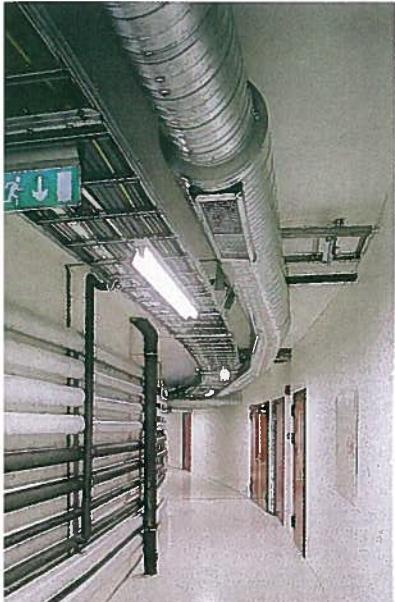
VVS-anlegget for bygningen omfatter sanitær-anlegg, luftbehandlingsanlegg, vannbårent varmeanlegg, isvannsanlegg for kjøling av ventilasjonsluft og kjøle-/fryserom.
